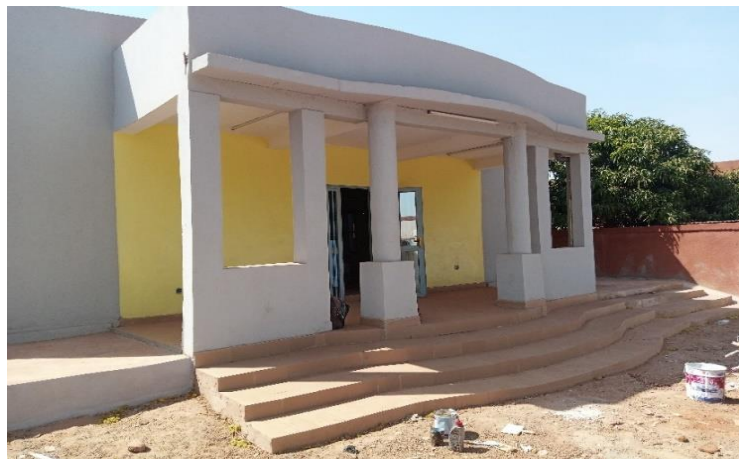
Photo 5 : Salle de réunion construite dans le cadre du programme (CVB/Ouahigouya)
